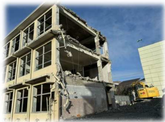
旧校舎に感謝！進む解体工事
